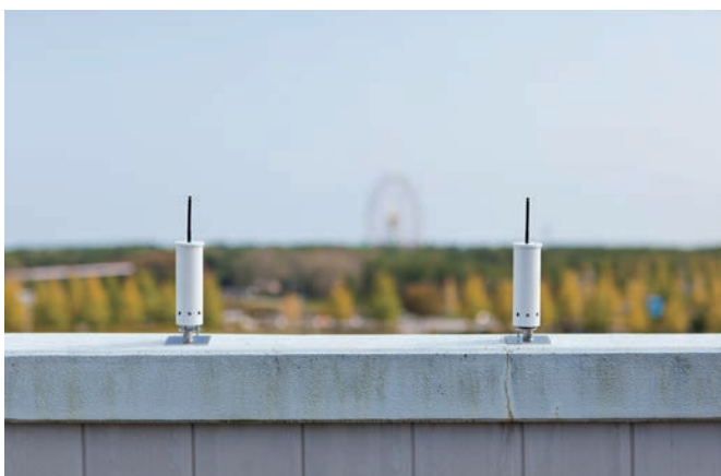
ビルやマンションの場合、屋上の壁や縁に装置をボルトで留めて設置します。
